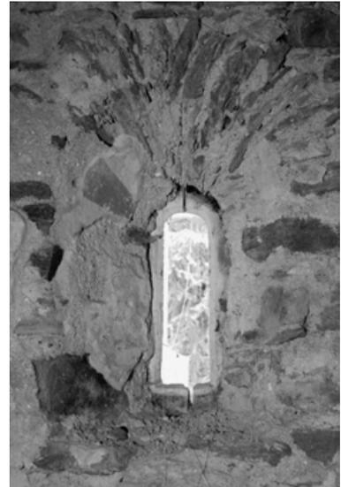
Abb. 14: Fenster mit originalem Fensterholz und Strahlenkranzmalerei im Chorscheitel
