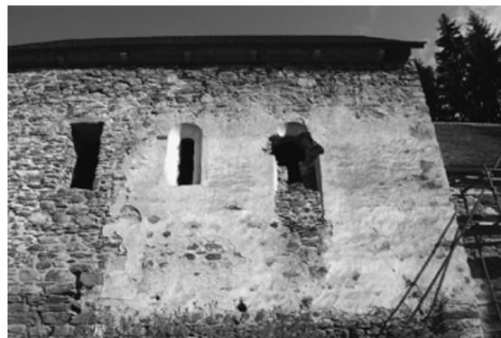
*Abb. 10: Südfassade mit tlw. erhaltenen Doppeltrichterfenstern*
